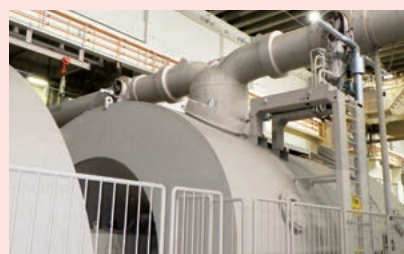
タービン解体撤去(作業前)
