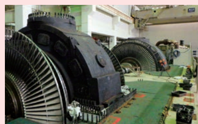
タービン解体撤去(作業中)
